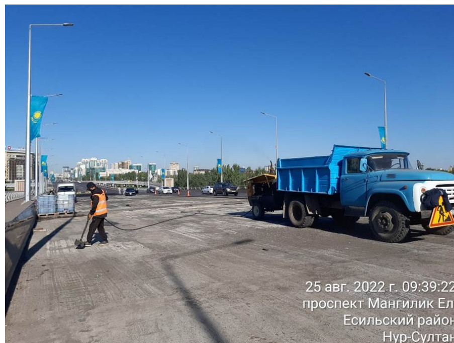
Рисунок 7 - Процесс очистки поверхности
