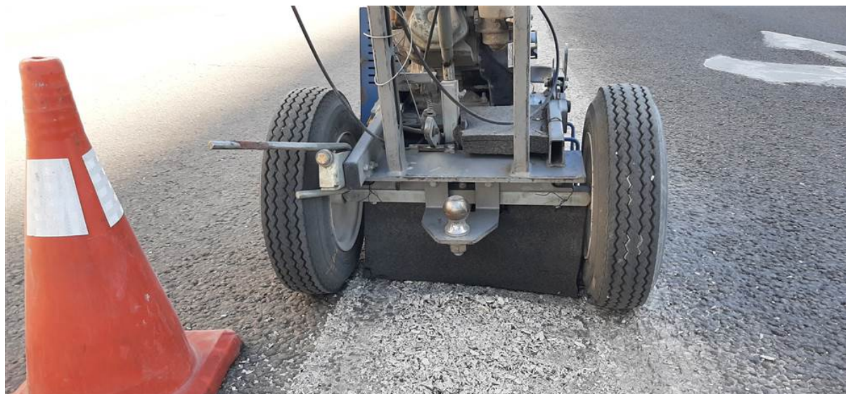
Рисунок 3 – Удаление дорожной разметки
