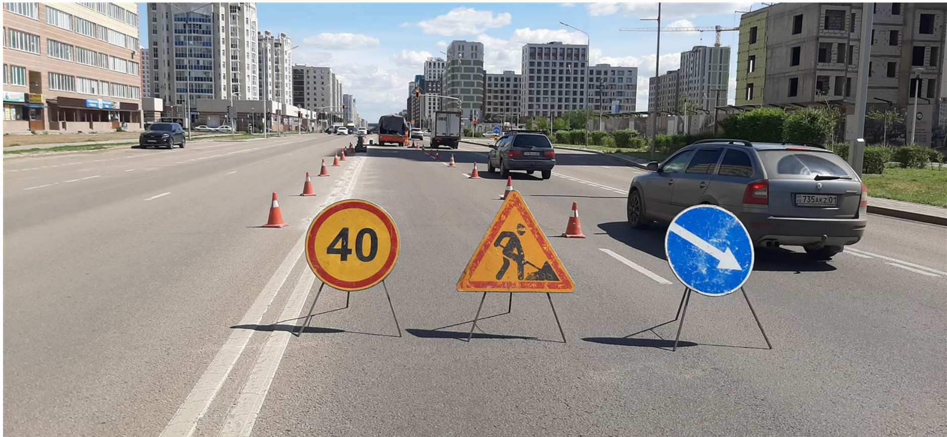
Рисунок 2 – Ограждение участка работ
