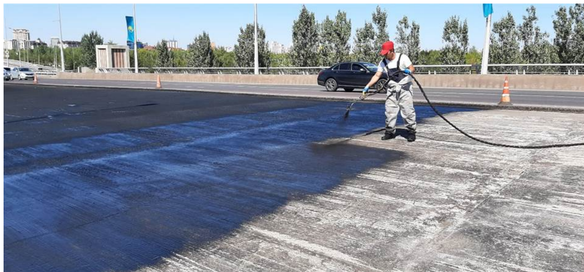
Рисунок 8 - Нанесение первого слоя Компонент «А»
