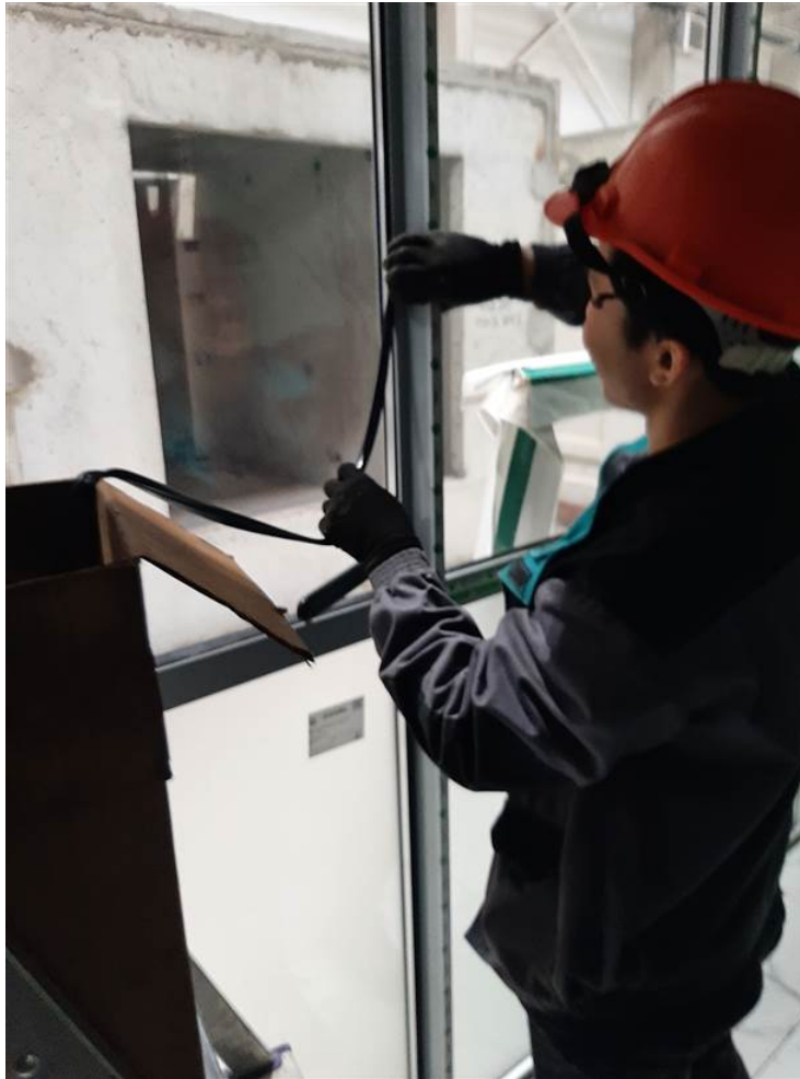
Рисунок 10 – Установка уплотнительной резины
