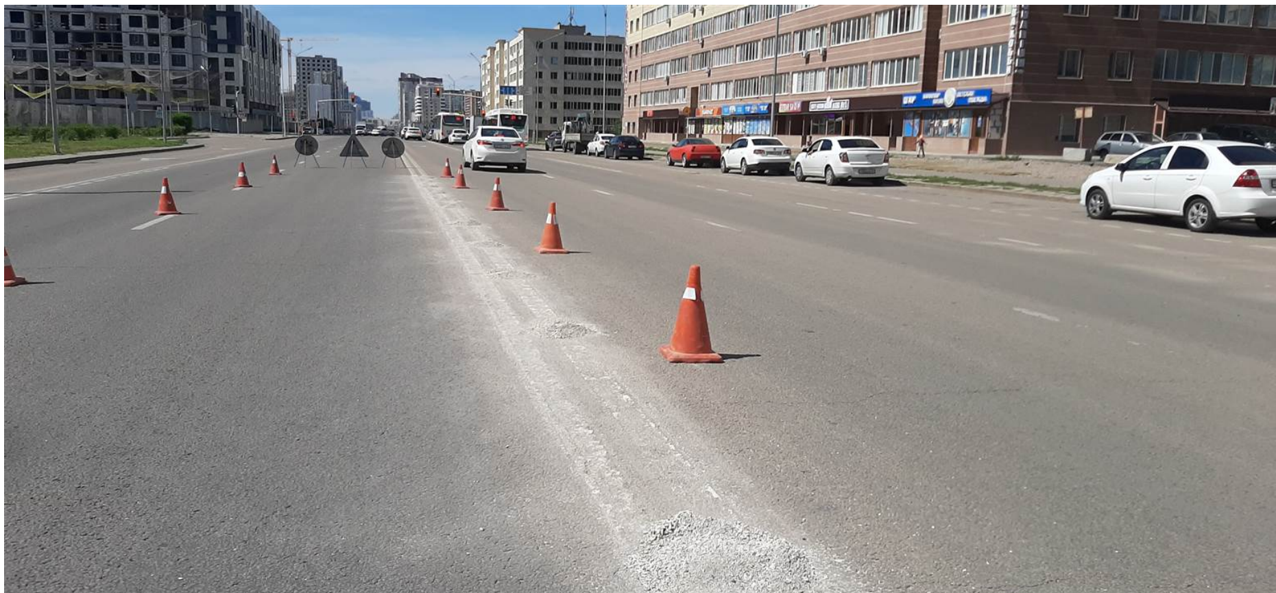
Рисунок 4 – Сбор удаленной дорожной разметки
