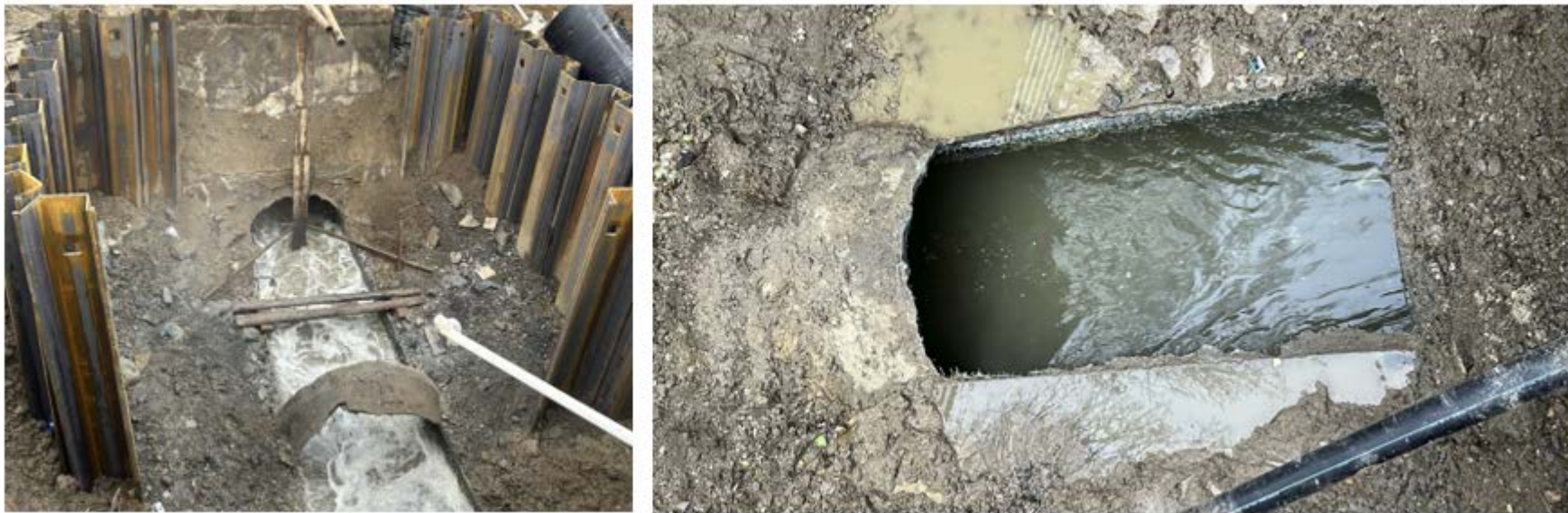
Рисунок 2.1 - Технологическая схема демонтажа верхней части трубы в котловане
