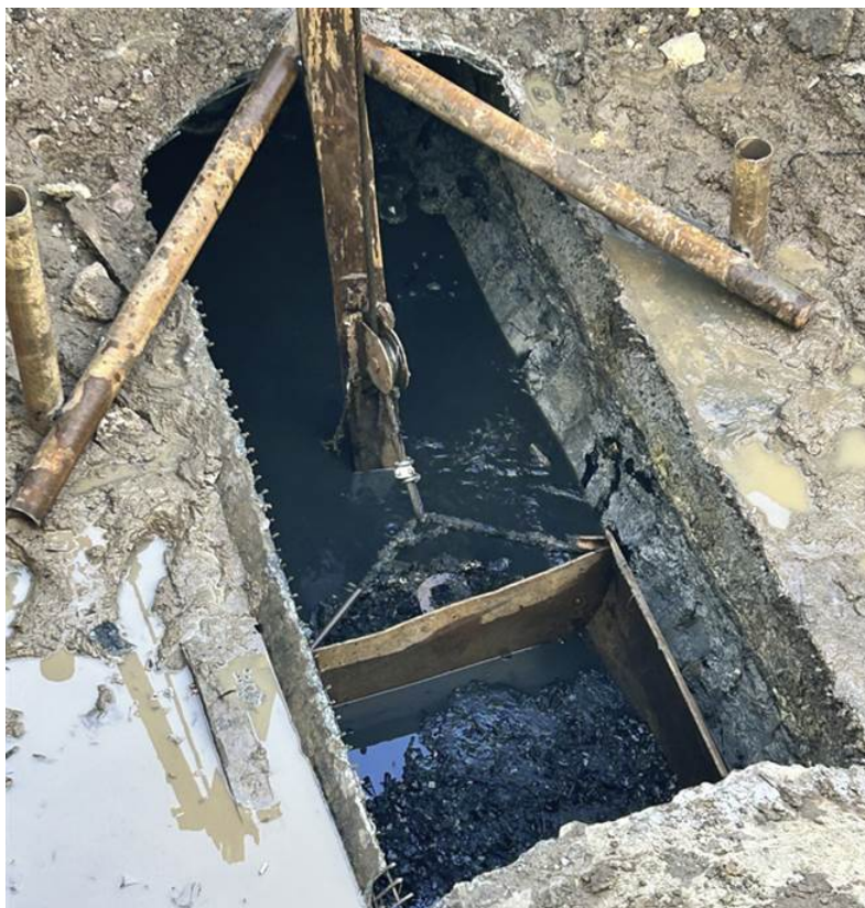
Рисунок 2.5 - Механическая прочистка трубопровода
