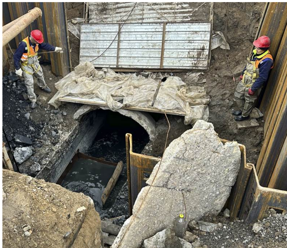
Рисунок 2.5 - Механическая прочистка трубопровода
