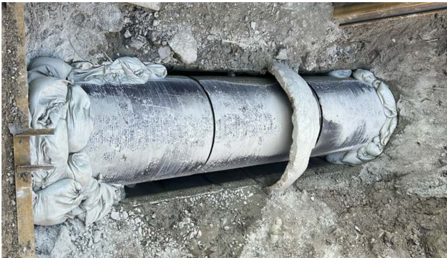
Рисунок 2.11 - Герметизация свода ж/б трубы в пределах котлованов
