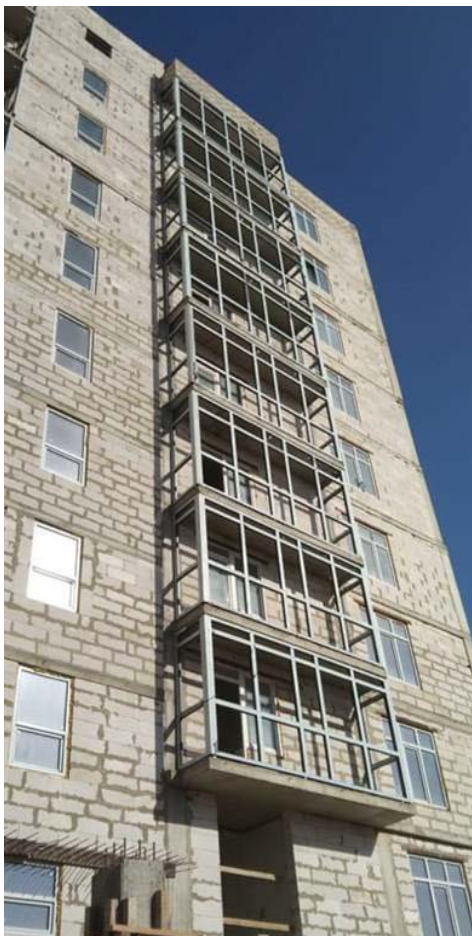
Рисунок 8 - Установка витражных блоков в проемы
