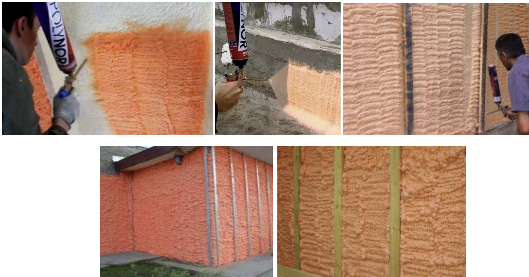
Рисунок 2.3 - Напыление полинора на поверхность
