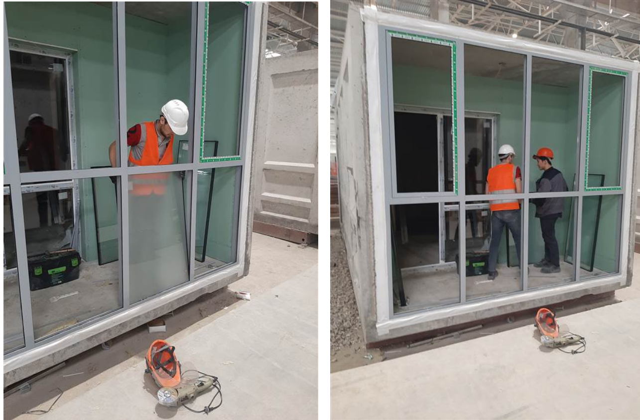
Рисунок 9 – Установка стеклопакетов
