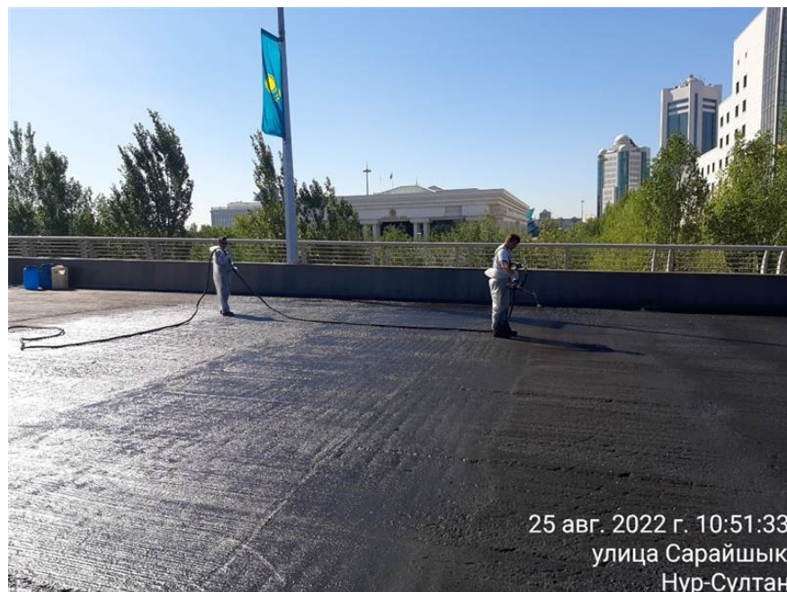
Рисунок 9 - Нанесение второго слоя Компонент «А» и «Б»
