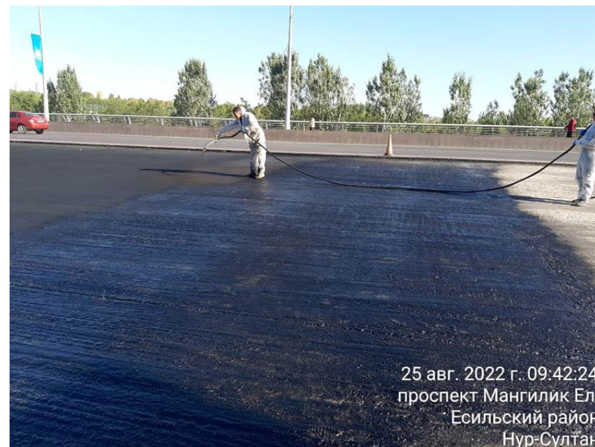
Рисунок 9 - Нанесение второго слоя Компонент «А» и «Б»
